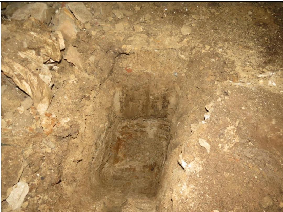
Шурф №3 выполнен внутри здания в подвале в осях 17-24/С (см. прил. В п. 14 и Графическую часть). По итогам произведенной выработки сделан вывод, что шурфом №3 вскрыт фундамент под стену, выполненный в виде бетонной фундаментной плиты размером 1500х300мм на естественном грунтовом основании. Ширина плиты – 450мм. Глубина залегания фундамента составляет 500 мм от уровня пола подвала. Глубина шурфа составляет 1000мм. Гидроизоляция фундамента отсутствует. Грунтовые воды в шурфе не встречены.
