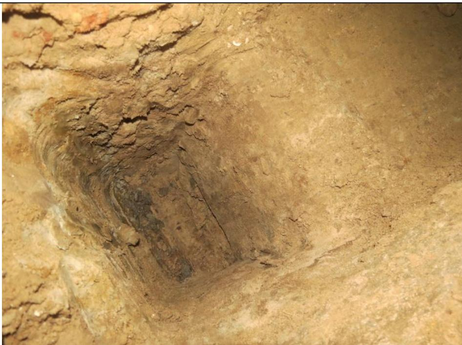
Шурф №1 выполнен внутри здания в подвале в осях 6/Б. По итогам произведенной выработки сделан вывод, что шурфом №1 вскрыт фундамент под колонну, выполненный в виде бетонной фундаментной плиты размером 1500х300мм на естественном грунтовом основании. Глубина залегания фундамента составляет 400 мм от уровня пола подвала. Глубина шурфа составляет 900мм. Гидроизоляция фундамента отсутствует. Грунтовые воды в шурфе не встречены.
