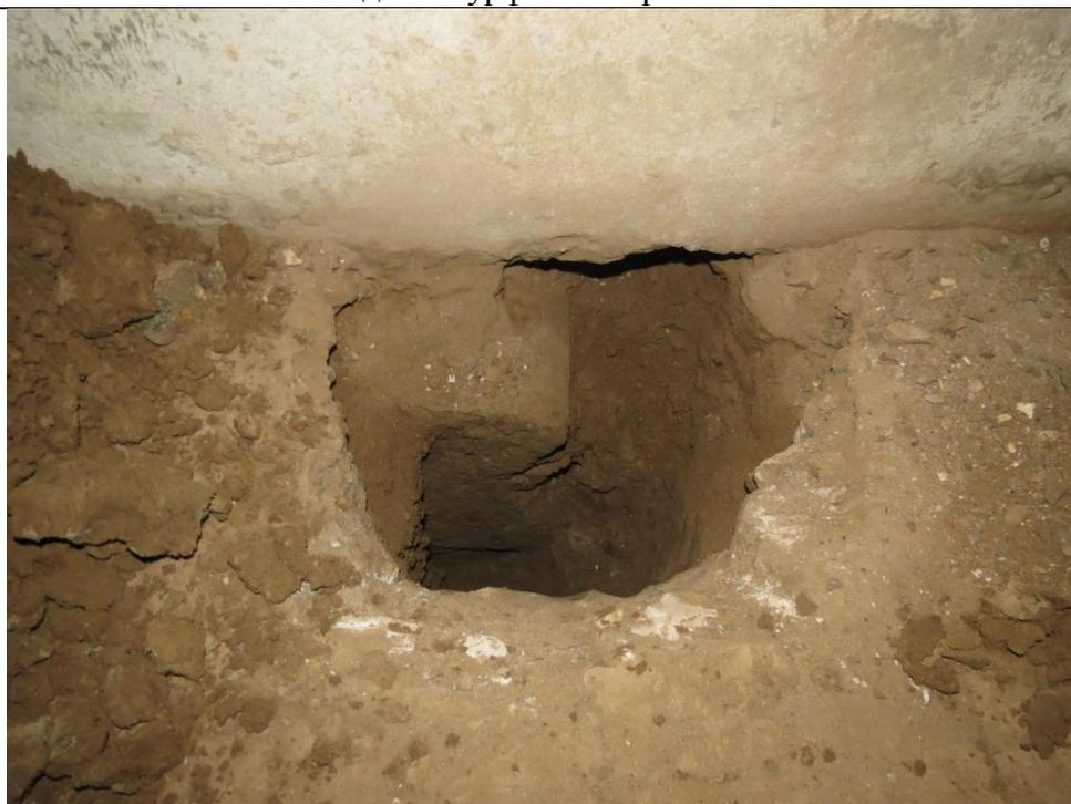
Шурф №2 выполнен внутри здания в центральной части здания. По итогам произведенной выработки сделан вывод, что шурфом №2 вскрыт фундамент под стену, выполненный в виде бетонной фундаментной плиты размером 1500х300мм на естественном грунтовом основании. Глубина залегания фундамента составляет 500 мм от уровня пола подвала. Глубина шурфа составляет 1000мм. Гидроизоляция фундамента отсутствует. Грунтовые воды в шурфе не встречены.
